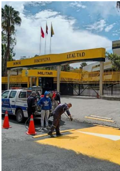
Reconstrucción del reductor de velocidades y colocación de señalética.
